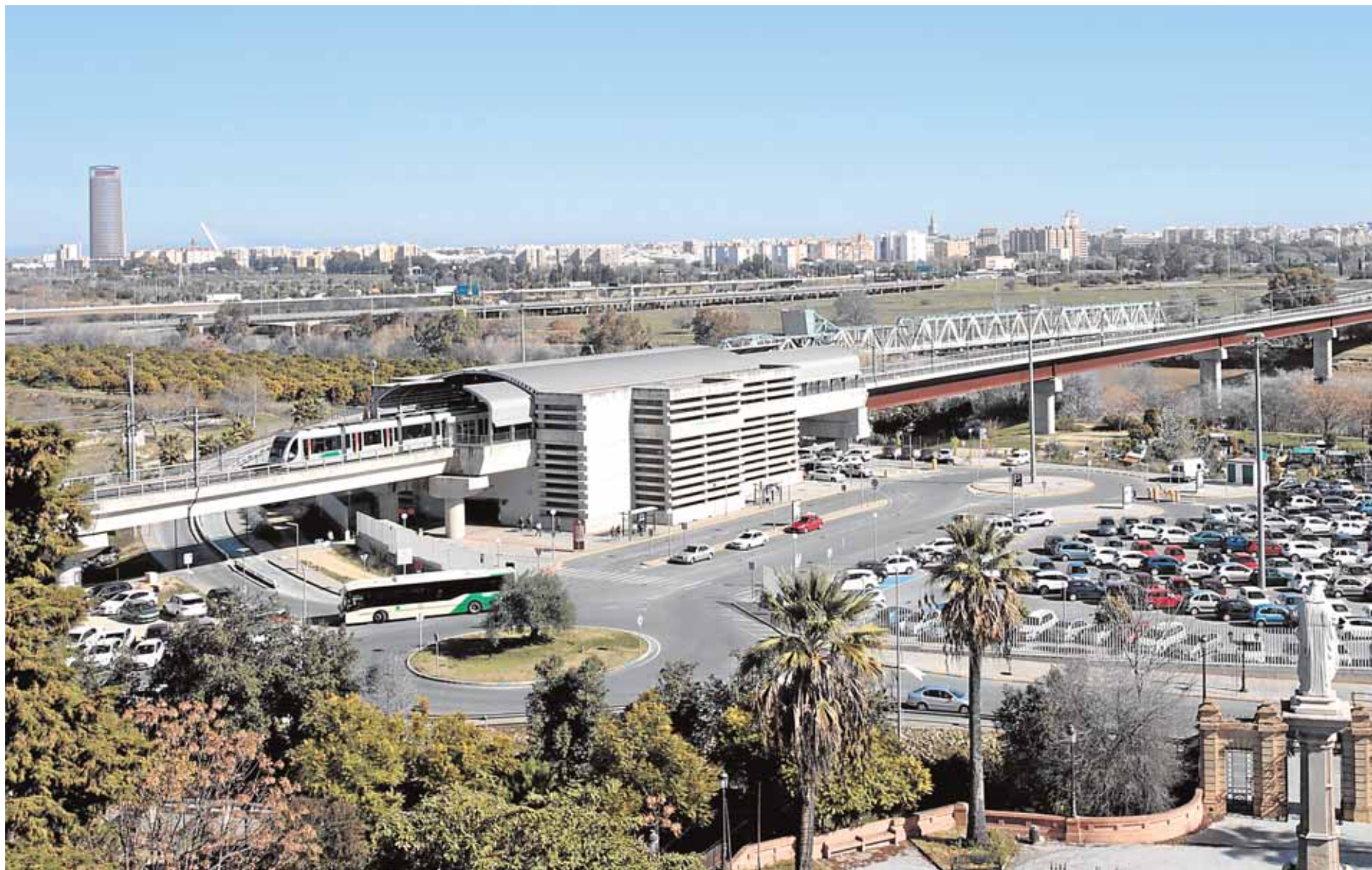
Estación de San Juan Bajo de la línea 1 del metro de Sevilla, que cubre desde el Aljarafe hasta Montequinto
